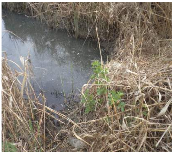
Szebeni utcai csapadékvíz elvezető tömény szennyvízzel terhelve
