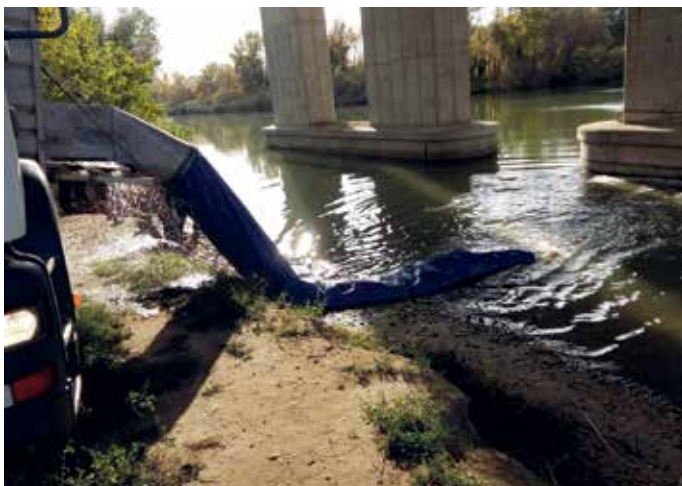
Telepítés az M0 híd alatt
