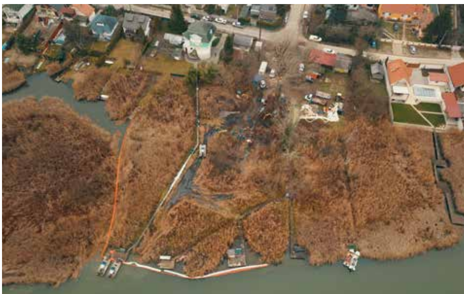
Az olajszennyezéssel érintett szigetszentmiklósi úszóláp merülőfalloal körbekerítve
