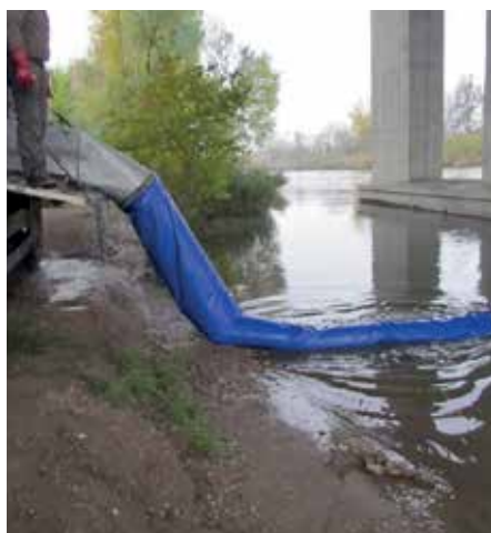
Telepítés az M0-híd alatt
