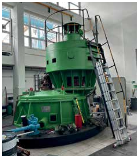
A projekt keretében felújított reverzibilis turbina (Fotó: Udvari Zsolt)
