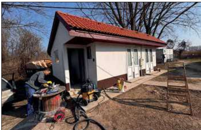
A régi vizesblokkot felújítottuk
